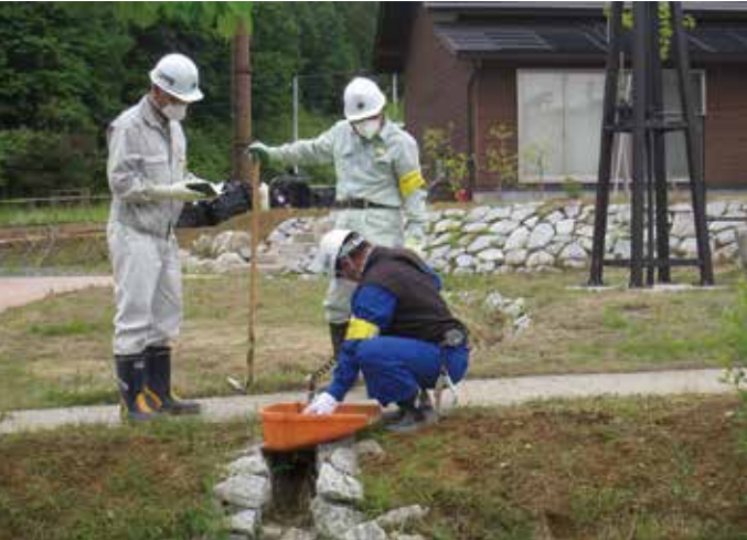
「までいな家」とその周辺を除染するようす。
