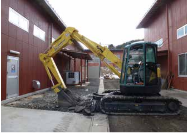
▲(株)菊池製作所のアスファルト切削
