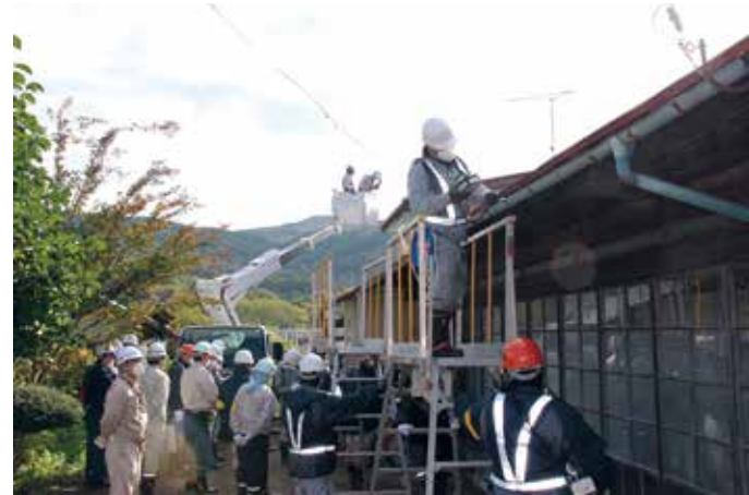
二枚橋地区で本格除染の作業が始まりました。複数の家屋の除染作業を並行し、面的に除染を行っています。
