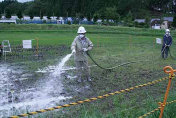
伊丹沢地区の水田において、固化剤を用いた表土はぎ取りなどの現地試験が農林水産省によって行われました。(24日、30日にも実施)。
