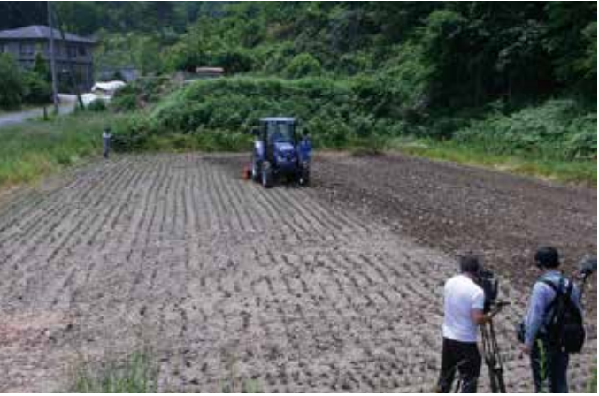
作物への放射性物質の移行を調べるため農林水産省が実施。表土をはぎ取ってから米を作付けする作業が、飯樋字八和木地内の水田で行われました。
